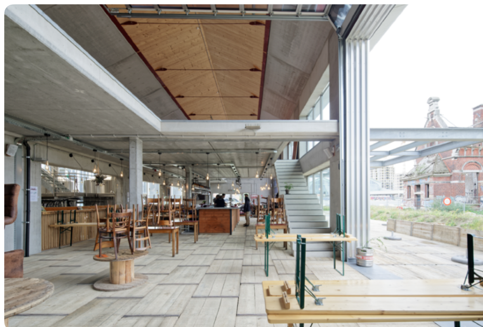
Réemploi de panneaux « steenschotten » en revêtement de sol et en terrasse. Brasserie de la Senne, Bruxelles (BE). Archi : La Générale © François Lichtlé.
