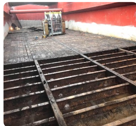
Démantèlement de cales de péniches © historischhout.nl
