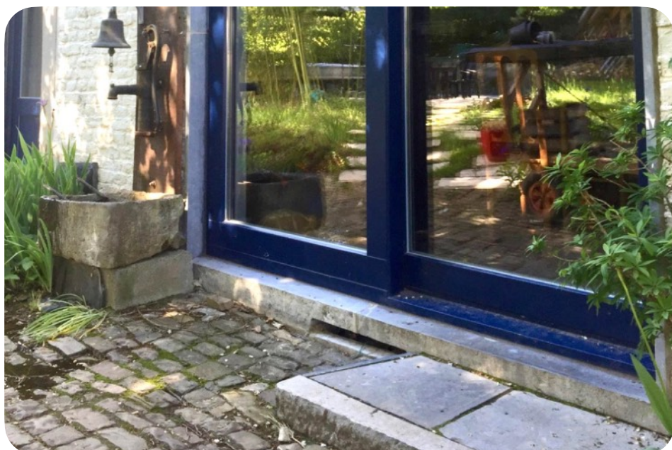
Inspiratie. Dorpel van een schuifraam, bestaande uit twee oude raamdorpels die op maat werden gezaagd en bewerkt om een ventilatie te voorzien voor de kelder (gat in het midden) © Sophie Boone
