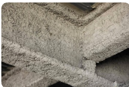
Poutrelles recouverte d'un flocage
