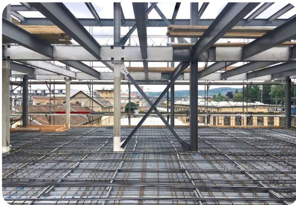
Remise en oeuvre des poutrelles
