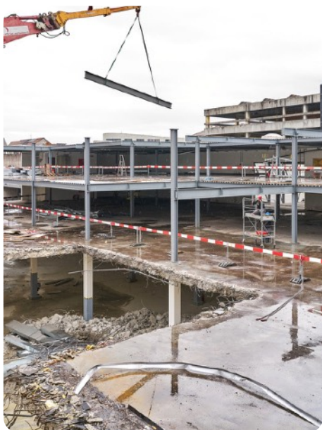
Récupération des poutrelles
