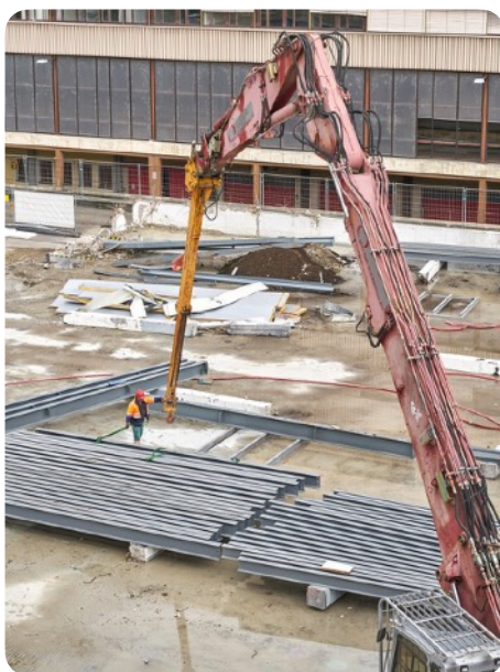
Récupération des poutrelles
