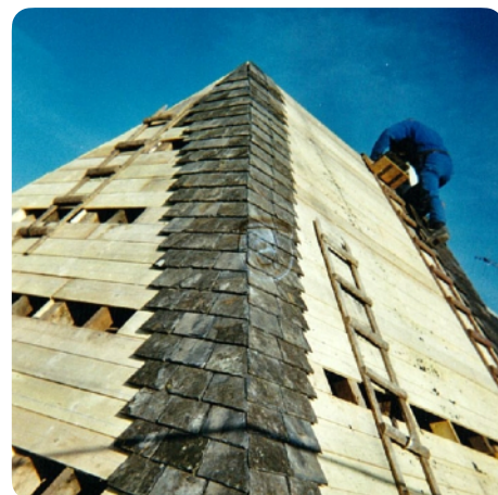
Pose clouée d'ardoise de réemploi, modèle épais, pose brouillée à pureau décroissant (FR) © Sarl Ritouet
