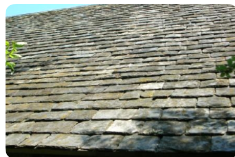
Pose clouée d'ardoise de réemploi, modèle épais, pose brouillée à pureau décroissant (FR) © Sarl Ritouet
