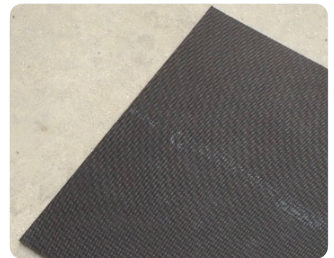
Envers d'une dalle de moquette posée sans colle.
