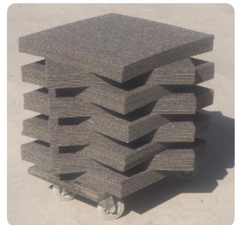
Déplacement de dalles au moyen de chariots. La disposition en quinconce facilite la manutention.
