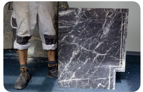
Kitvoeg en uitgezaagde hoek voor inbouw van het tablet. © Frédéric Uyttenhove
