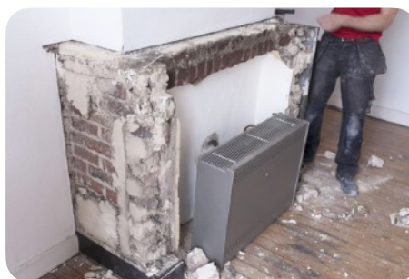
Demontage van een schoorsteenmantel
