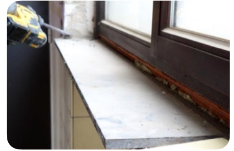
Vrijmaken van de uiteinden van het tablet
