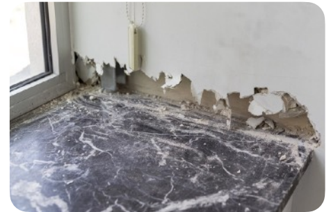
Vrijmaken van de uiteinden van het tablet
