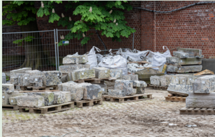
Opslag van verwijderde stenen elementen Kazerne van Elsene © Ekkow Photography – Buildwise
